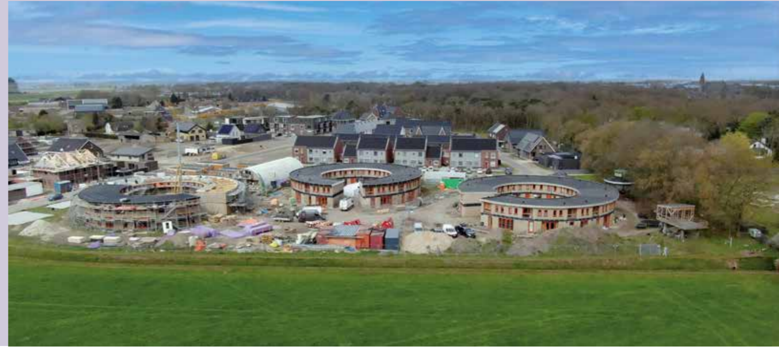
IN HET ECODORP BOEKEL STONDEN DUURZAAMHEID EN CIRCULARITEIT AAN DE BASIS VAN HET BOUWPROCES EN KOOS MEN ALS DAKBEDEKING VOOR EPDM INDUCTIESYSTEMEN VAN HERTALAN.
