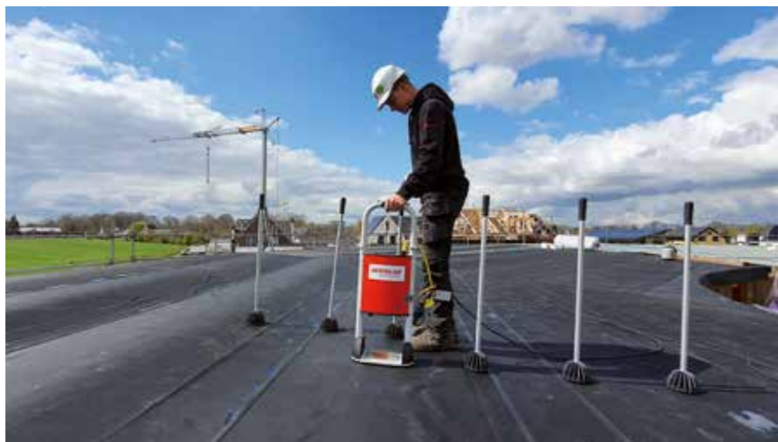
AANLEG DAKBEDEKING VAN CARLISLE MET BEHULP VAN INDUCTIE.
