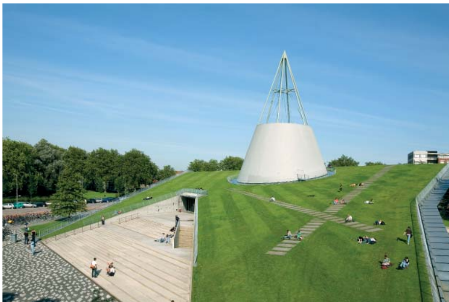
EPDM toegepast op het dak van de TU Delft bibliotheek
