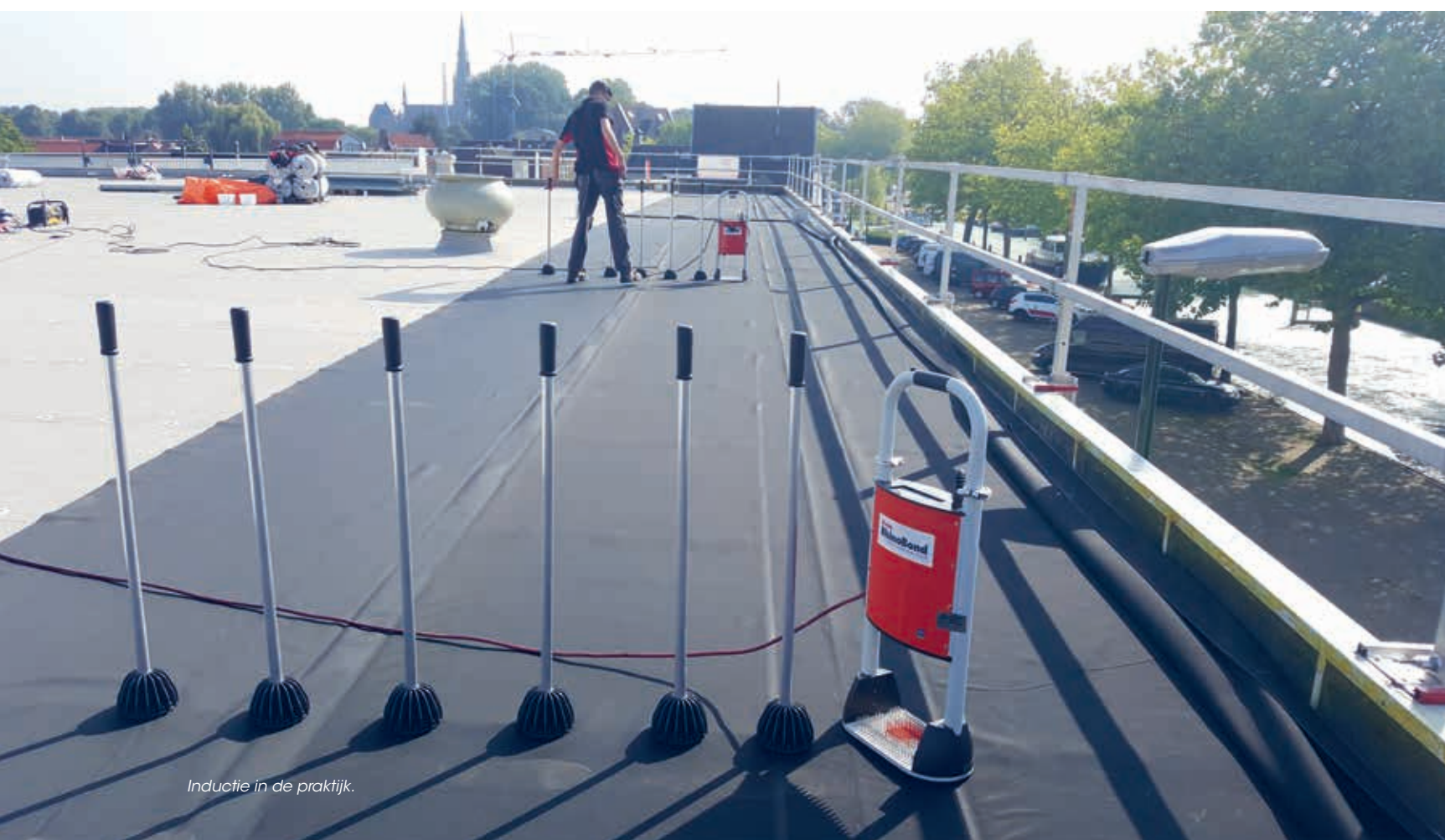
Mechanische bevestiging door middel van inductie.
