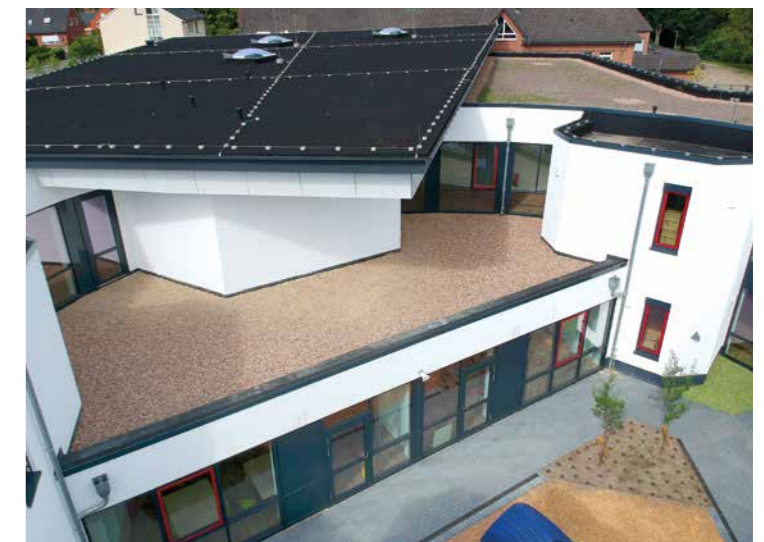
Nach nur 16 Monaten Bauzeit wurde der Neubau pünktlich zum Beginn des Schuljahres 2019/2020 fertiggestellt.
