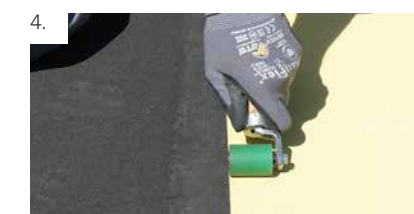
4. DIE RÄNDER WERDEN ZUSÄTZLICH MIT EINER BREITEN STAHLROLLE (ALTERNATIV SILIKON)ANGEDRÜCKT.
