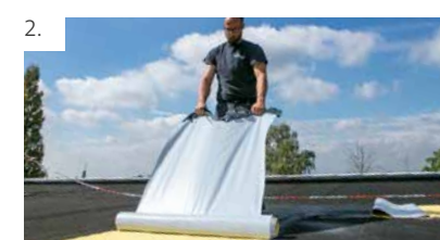
2. NACH DER WITTERUNGSBEDINGTEN ABLÜFTZEIT WALKWAY AUSROLLEN UND AUSRICHTEN. ANSCHLIESSEND DIE FOLIE ABZIEHEN.
