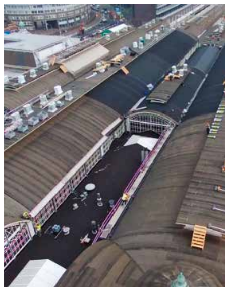
▲ Riesenprojekt: Die Dachflächen des Bahnhofs sind zusammen über 10000 m 2 groß
