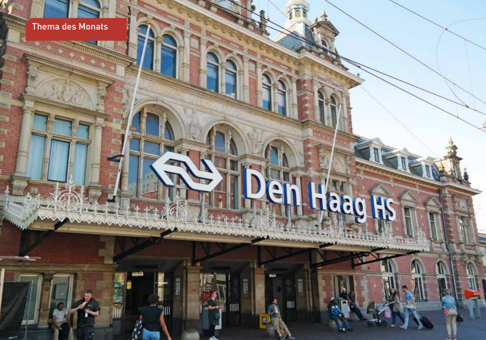
▲ Kulturgut: Der 1843 eröffnete Bahnhof Hollands Spoor in Den Haag verfügt über eine imposante Ziegelfassade und steht deshalb unter Denkmalschutz
