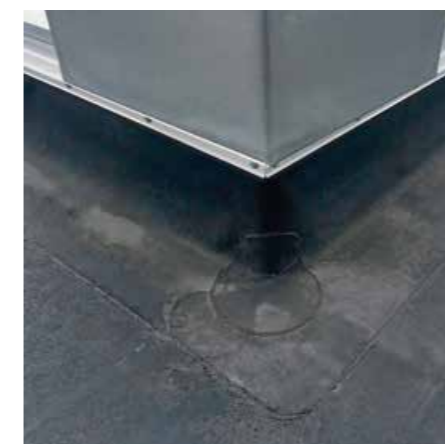
▲ EPDM im Detail: Anschluss an eine Lichtkuppel
