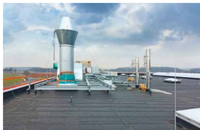
▲ Fertige Dachfläche im Produktionsbereich mit vielen Detailausbildungen
