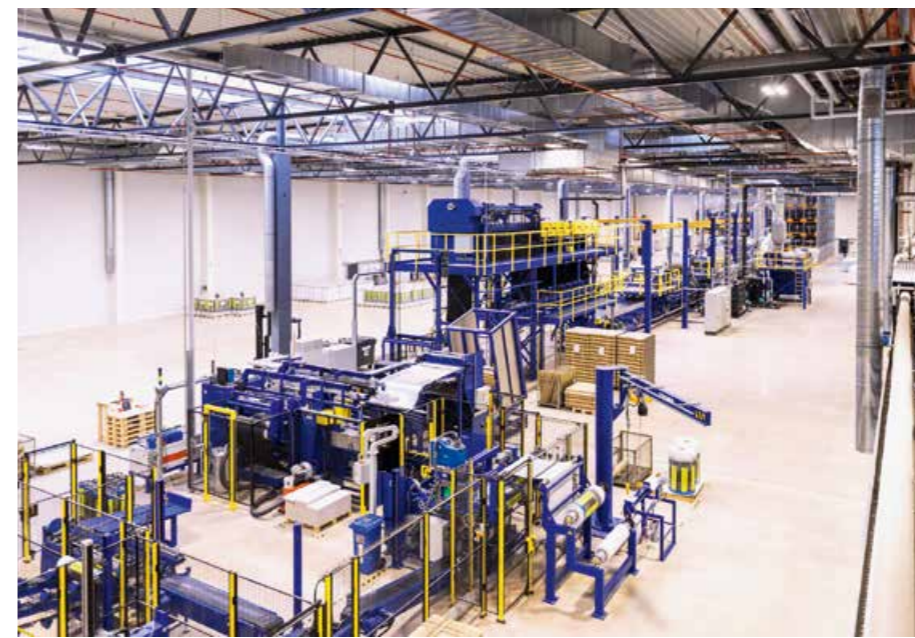
▲ Kapazität verdoppelt: Überblick über die neuen Produktionsanlagen für EPDM-Bahnen
