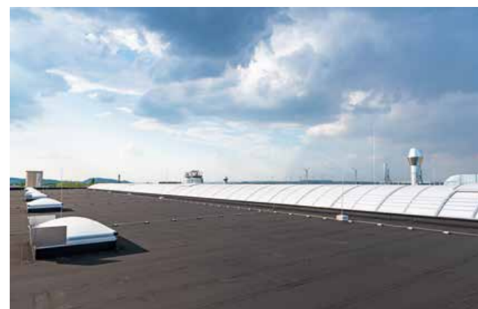
▲ Als Dachabdichtung wurden Bahnen aus eigener Herstellung eingesetzt
