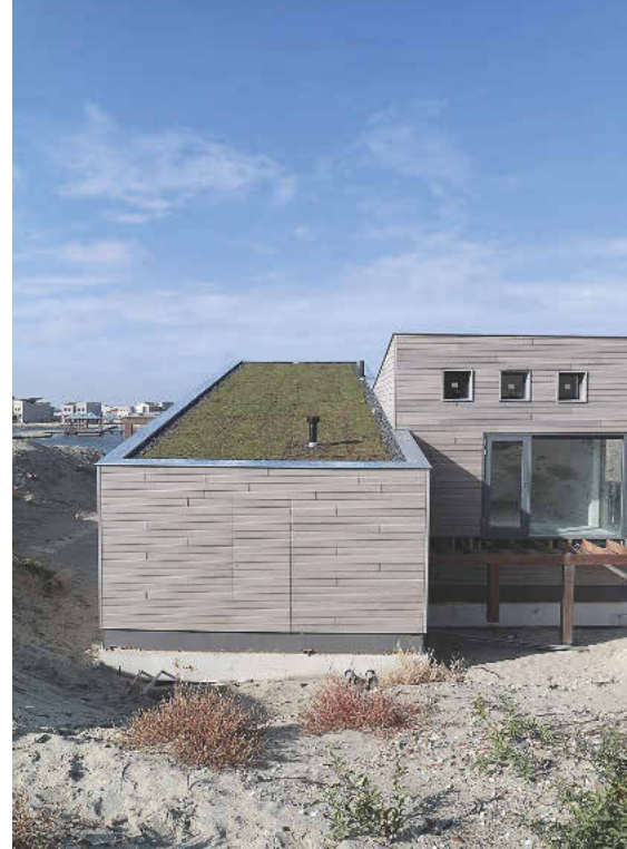
Nach der vollflächig windsog-sicheren Verklebung der EPDM-Dichtungsplanen erhielten die Dachflächen eine Begrünung mit Moos-Sedum.
