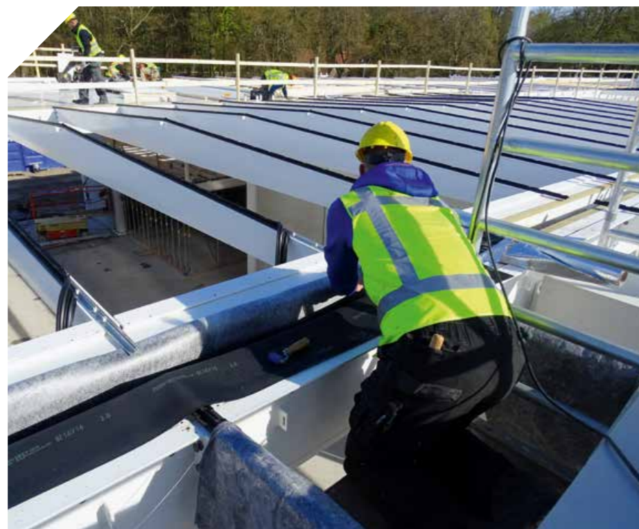
▲ Für die Abdichtung der ins Dach eingearbeiteten Regenrinnen nutzen die Dachdecker Zuschnitte
