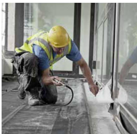
▲ Der Anschluss an die Betonattika erfolgte mit einem speziellen Kontaktkleber
