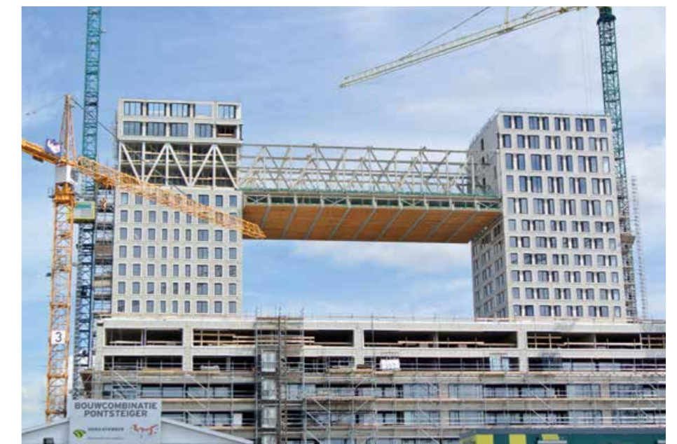
► Die riesigen Stahlbinder der Brücke sind fast 50 m lang und wiegen bis zu 78 t
