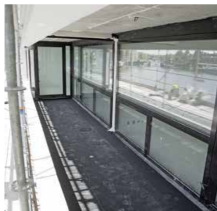
▲ Die Planen – insgesamt 3000 m 2 – wurden von den Dachdeckern lose verlegt
