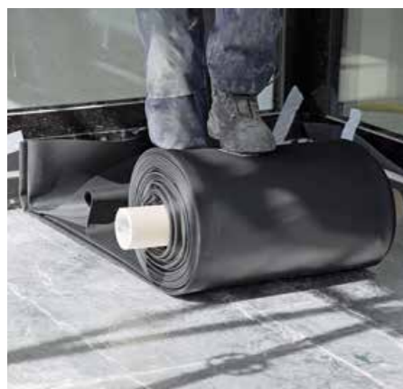
▲ Die Abdichtungsplanen der Loggien wurden nach Aufmaß in einem Stück gefertigt
