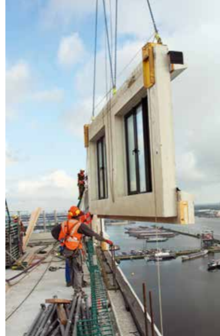
▲ Ein Kran hebt die Bauteile zum Einbauort
