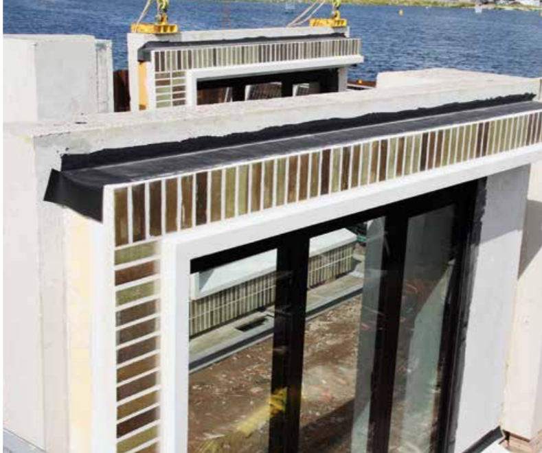
▲ Einbaufertig: Die großen Fassadenelemente mit EPDM-Anschlussstreifen
