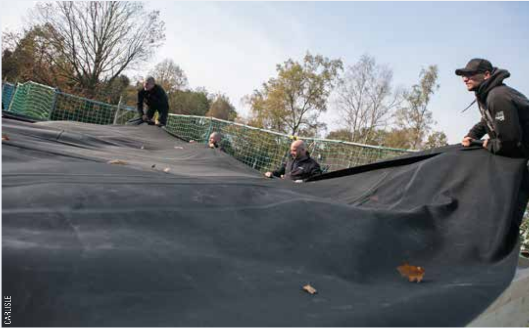
Die Plane wird auf dem Dach ausgerichtet.
