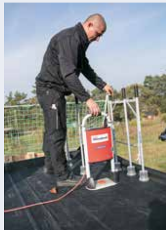
Zur Verschweißung der Planenunterseite mit den Haltetellern wurde das Induktionsgerät genau über den einzelnen Tellern positioniert.
