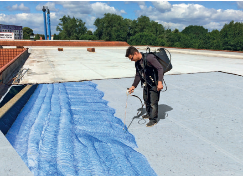
Auftrag der neuen Flächengrundierung FG 40 mit dem Spritzgerät
