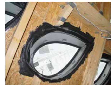
▲ Die tropfenförmigen Oberlichter wurden mit EPDM-Streifen abgedichtet
