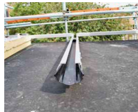
▲ Die Unterkonstruktion für die Edelstahlpaneele über der EPDM-Abdichtung
