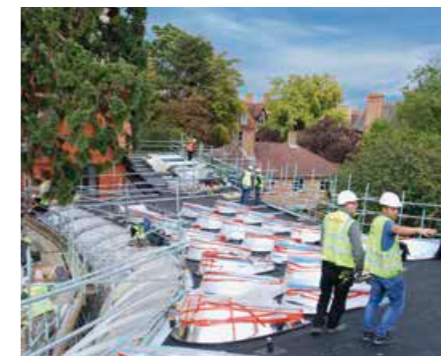
▲ Die Integration der Oberlichter in die Flächenabdichtung erforderte viel Sorgfalt
