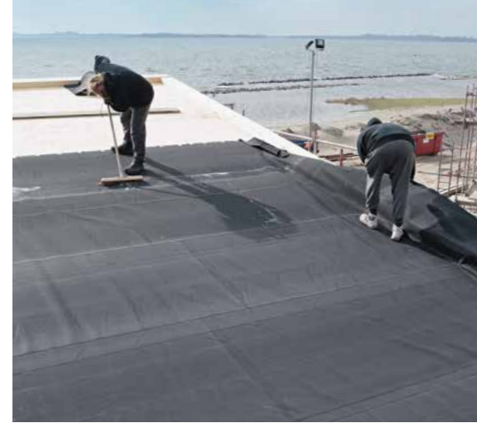
▲ Nach der Ausrichtung wurde die Plane mit dem Besen angedrückt
