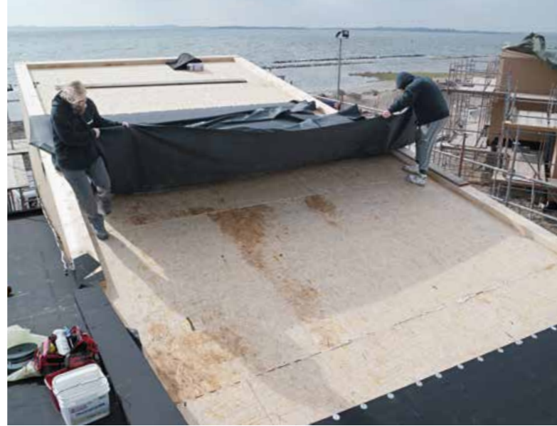
▲ Danach erfolgte die Ausrichtung der maßgeschneiderten EPDM-Planen
