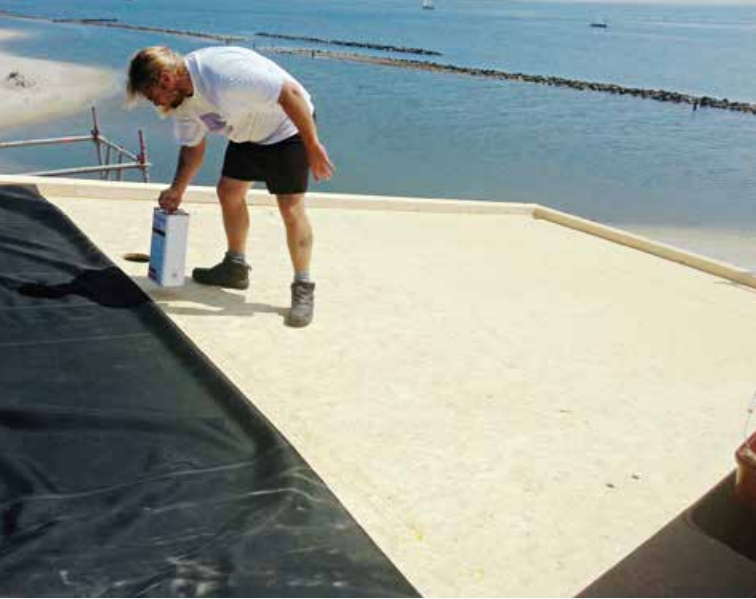
▲ Zunächst wurde der Flächenkleber auf die OSB-Schalung aufgetragen
