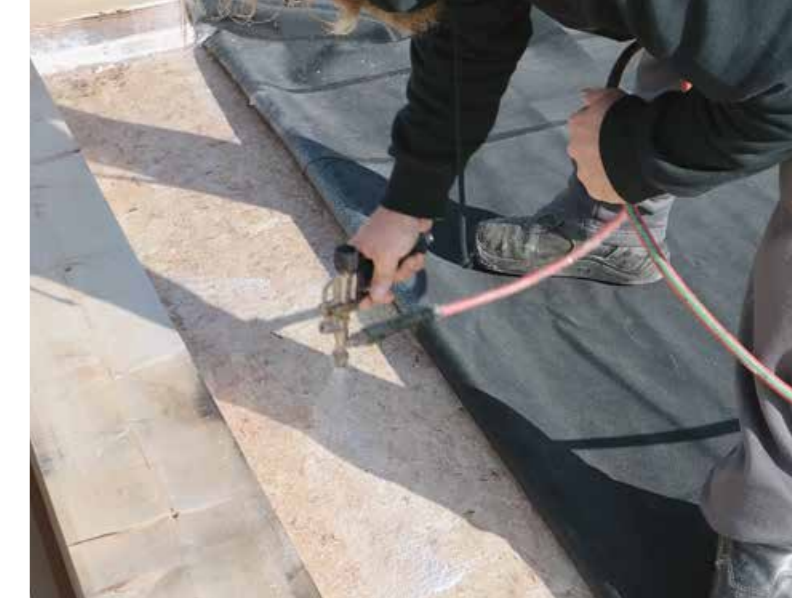
▲ Detailarbeit: Auftrag eines Kontaktklebers im Randbereich eines Dachs
