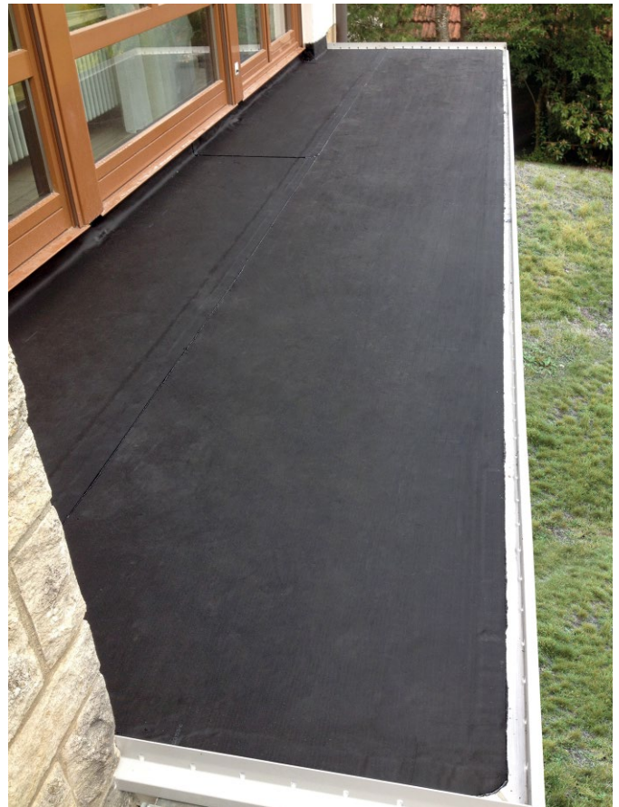
Bild 2. Balkonabdichtung mit RESITRIX® SK W Full Bond, vor der Montage der Brüstung.
