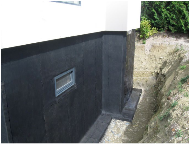
Bild 3. Kellerwandabdichtung mit RESITRIX® SK W Full Bond vollflächig, selbstklebend verlegt.
