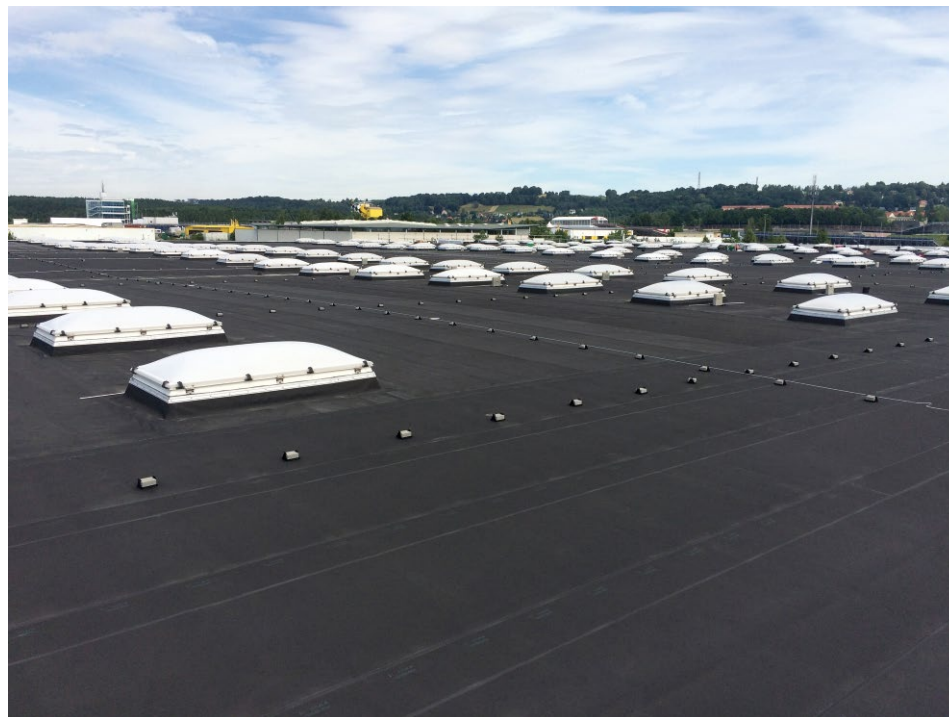
Bild 1. Industriedachsanierung mit HERTALAN® Planen und vorkonfektionierten Lichtkuppelmanschetten auf vorhandener Kunststoffabdichtung.
