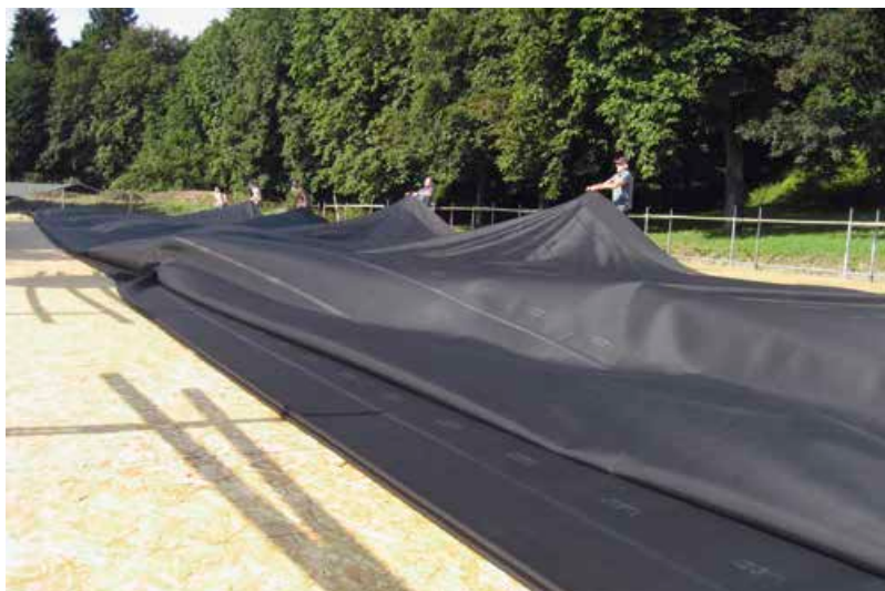
Auslegen einer großflächigen Gründachplane Hertalan Easy Cover auf OSB-Untergrund mit anschließender Feinjustierung
