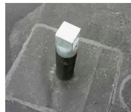
▲ Die Stahlfundamente der Fensterreinigungsanlage wurden mit 198 individuell angefertigten Manschetten in die EPDM-Abdichtung eingebunden
