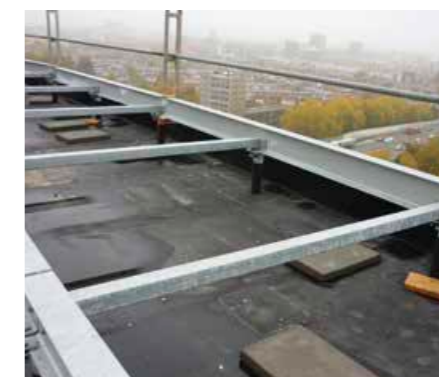
▲ Die Stahlfundamente der Fensterreinigungsanlage wurden mit 198 individuell angefertigten Manschetten in die EPDM-Abdichtung eingebunden
