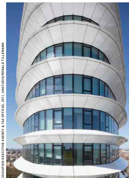
▲ Innovativ: Die weißen Fassadentafeln »regeln« den Lichteinfall ins Gebäude
