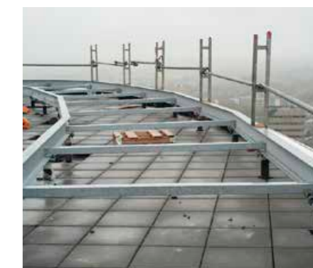
▲ Die Stahlfundamente der Fensterreinigungsanlage wurden mit 198 individuell angefertigten Manschetten in die EPDM-Abdichtung eingebunden
