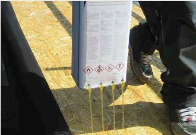
▲ Das Planenmaterial kann teil- oder vollflächig mit einem Polyurethan-Klebstoff verklebt werden
