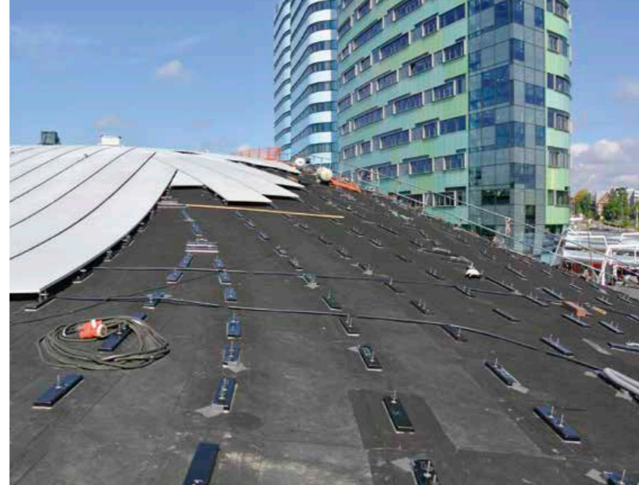
▲ Die Haut des Wals: Die hellgrauen, maßgefertigten Betonplatten liegen über einer äußerst robusten EPDM-Abdichtung, der eine Gebrauchsdauer von über 50 Jahren bescheinigt wird
