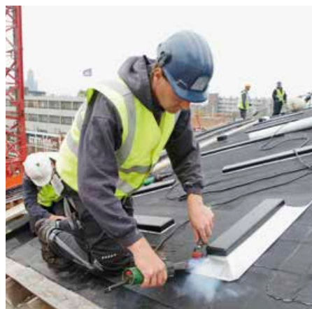
▲ Detailarbeit: Die Befestigungspunkte mussten in die Abdichtung eingebunden werden
