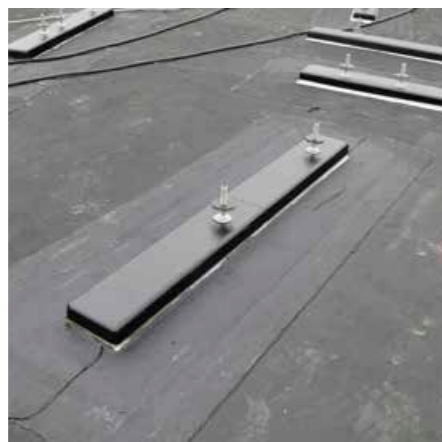
▲ Dauerhaft dicht: Dieser Detailpunkt ist fertig, das Betonelement kann kommen
