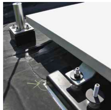
▲ Befestigung: Die vorgefertigten Dachelemente bekleiden eine 3000 m 2 große Fläche
