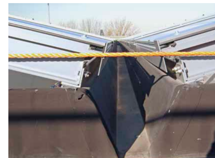
▲ Die Rinnen wurden untereinander mit EPDM-Streifen verbunden
