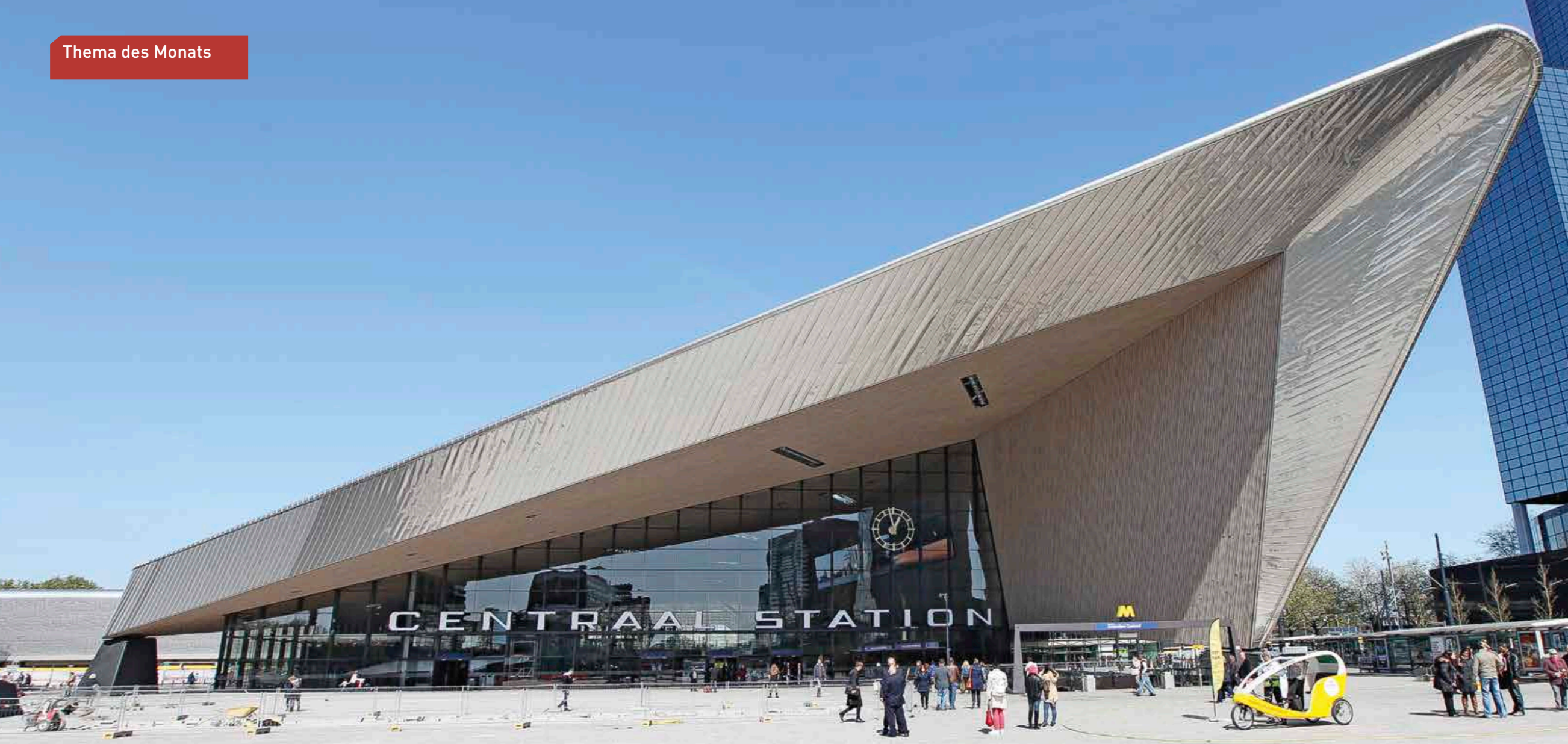
▲ Die glänzende Edelstahlfassade des Hauptbahnhofs bildet das Portal zum modernen Stadtzentrum
