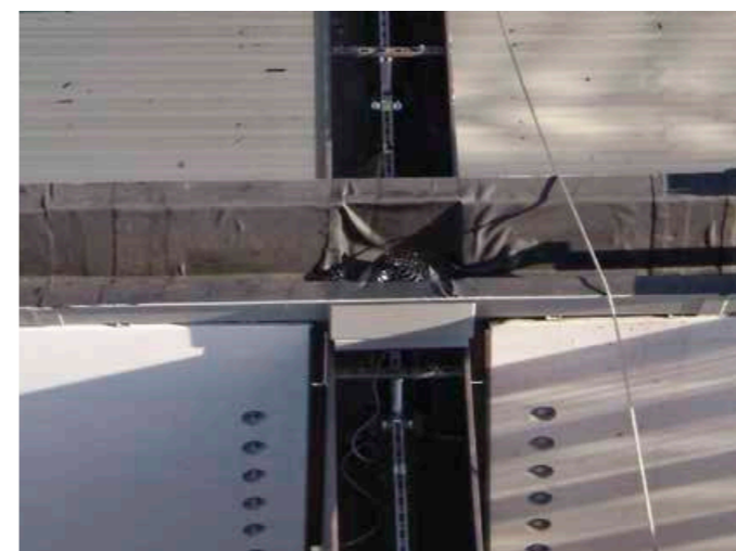
▲ Die EPDM-Formteile bauten die Handwerker bereits in der Werkstatt ein
