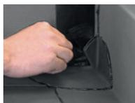
Schutzfolie im Bereich der Quetschfalte entfernen und diese mit Heißluft verschweißen.
