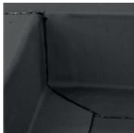
Gehrungsschnitt im Bereich der Dachfläche durchführen und anschließend den zweiten Anschlussstreifen verschweißen.
