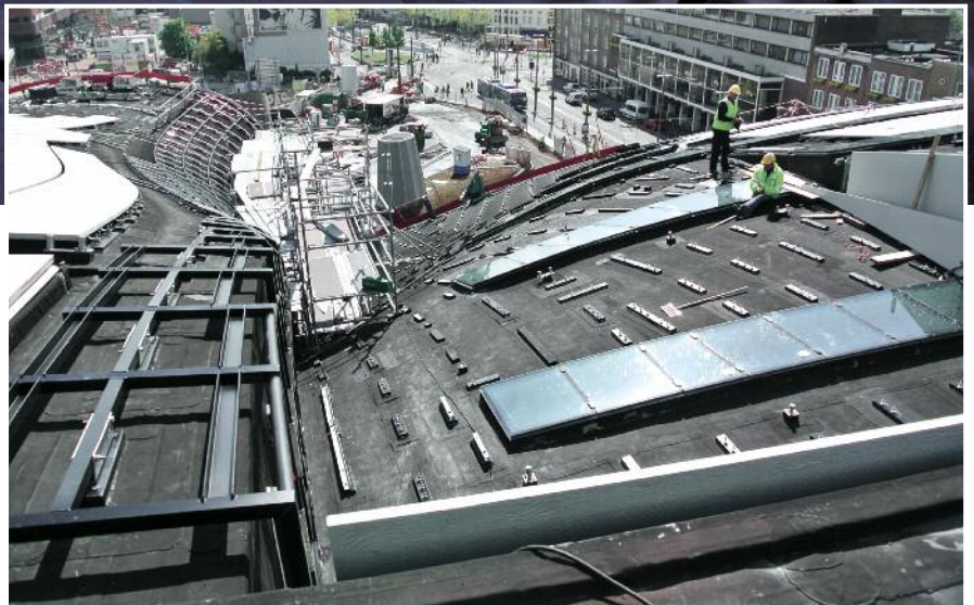
Bahnhof Arnheim: Resitrix SK W Full Bond auf Stahlträgern
