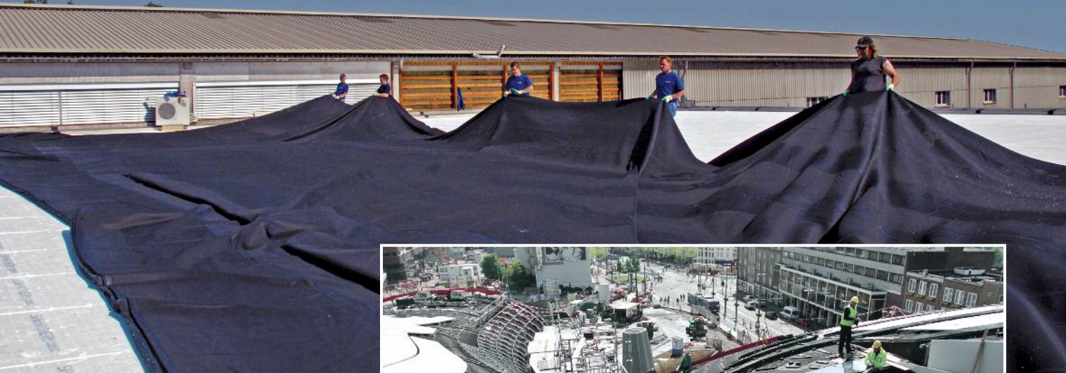
Ausrollen und Verlegen der Hertalan-EPDM-Plane durch Unterwedeln von Luft
