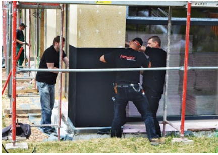
Bild 2. Start der Verkleidung – die erste Bahn wird verlegt
