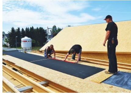
Bild 3. Zuschnitt der Fassadenplatten auf Maß
