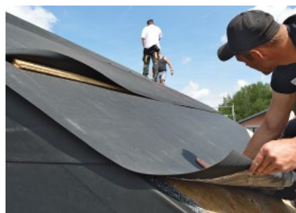
Bild 6. Nach dem fertigen Ausrollen der Bahn sind bereits die nächsten 20 m² abgedichtet (Fotos: Carlisle Construction Materials)
