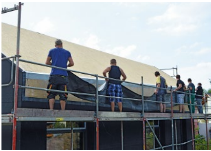
Bild 4. Große Herausforderung an die Verlegekräfte durch 13 m lange Bahn an einem Stück
