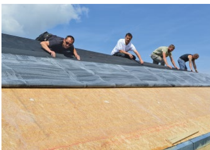
Bild 5. Ablassen der 13 m langen Dachbahn – jetzt rollt sie von allein
