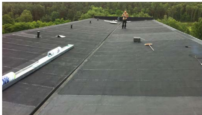
Bild 2. Flachdachabdichtung mit innenliegender Entwässerung (Fotos: Carlisle Construction Materials)
