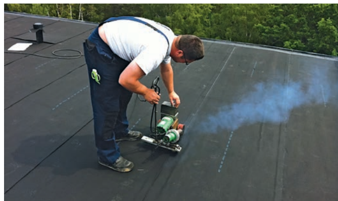
Bild 1. Heißluft-Verschweißung mit Schweißautomat
