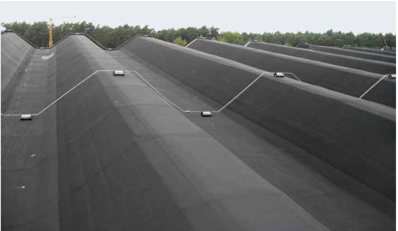
Beispiel eines sanierten VT-Faltendaches mit selbstklebenden EPDM-Dachbahnen
