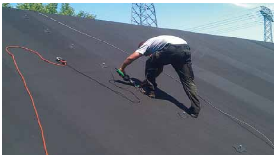
Foto: Rogro Dachtechnik
