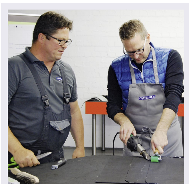
Schürze an, Handfön auf höchste Stufe und dann ran an die Bahn – für unseren Fachredakteur, Dachdeckermeister Michael Zenk (rechts), war die Nahtschließung der EPDM-Bahnen natürlich ein Leichtes.
