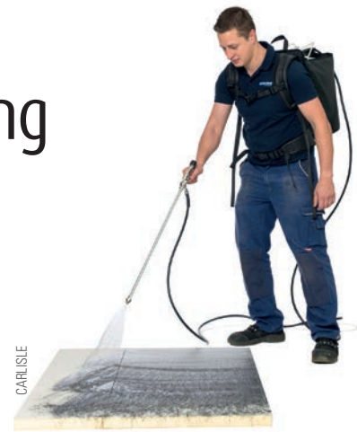
Verarbeitung der Flächengrundierung »FG 35« mittels Spritzgerät im Tragerucksack.
