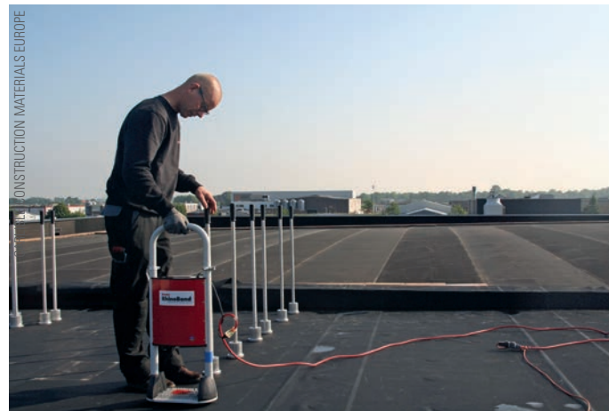
Die EPDM-Plane wird mittels Induktion mit den Haltetellern verschweißt.
