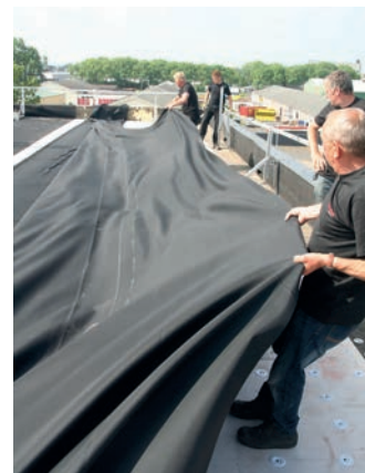
Ausbreiten der Plane durch Unterwedeln von Luft.
